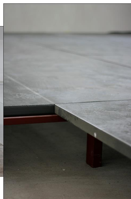
Fot.11. Suszarnia komorowa. Podłoga sitowa z paneli ułożonych na konstrukcji nośnej.
